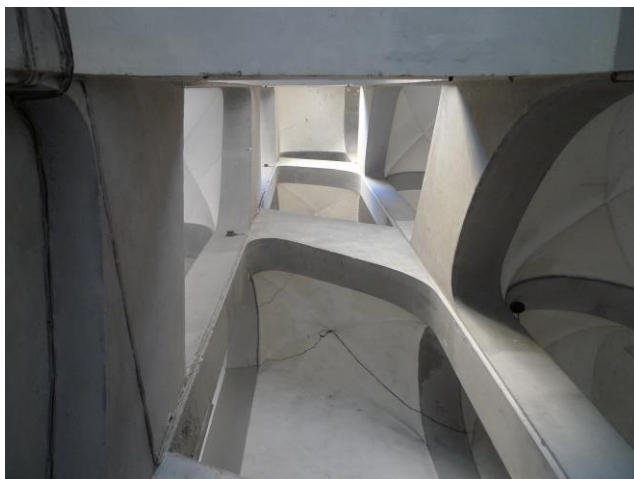
Figg. 8-9. La scala aperta del blocco su via Nardones; scorcio della struttura a volte rampanti.
