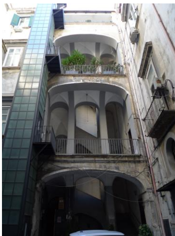
Figg. 8-9. La scala aperta del blocco su via Nardones; scorcio della struttura a volte rampanti.
